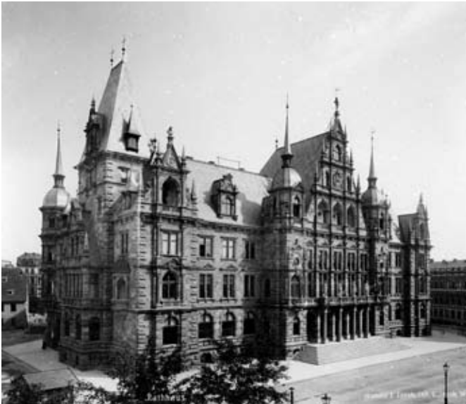
Das neue Rathaus, erbaut 1887, nahm seit 1892 das Wiesbadener Stadtarchiv auf (Foto: Stadtarchiv Wiesbaden).
